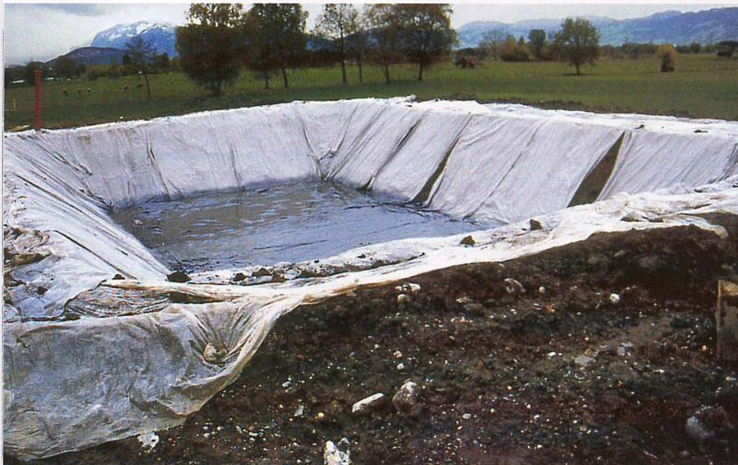
Der Bau einer Güllelagune bzw. eines Gülleerdbeckens beginnt mit Baggerarbeiten. Dabei kann das Aushubmaterial oder anderes Erdmaterial zum Bau des Erdwalles verwendet werden.
